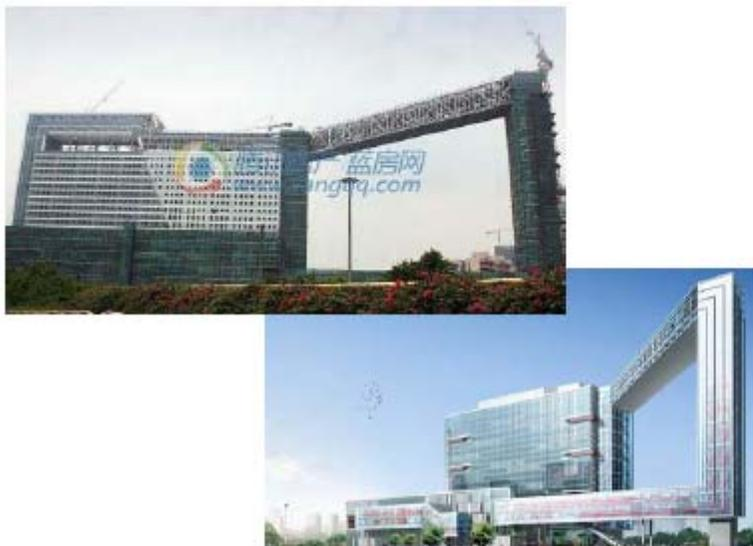
增加采用弹性楼板，型钢混凝土构件，
